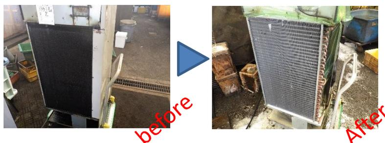
熱交換器に汚れがたまり、熱交換がスムーズに行われなくなると、電力費の上昇や、加工誤差の原因となる場合があります。熱交換器を定期的に洗浄することにより、余分な電力を削減したり生産の効率化を図れます。
